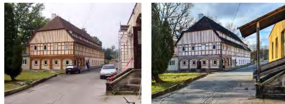
Obr. 9 – Vilémov č.p. 4 - 2003 vs. 2022 – nízký stupeň neregulovaných změn; zdroj: 2003 - TUR Šlukovsko, 2022 - archiv autora
