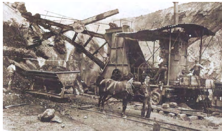
Obr. 2 – Povrchová těžba v dole pomocí parního rypadla – snímek z roku 1885 (osobní archiv autora)
