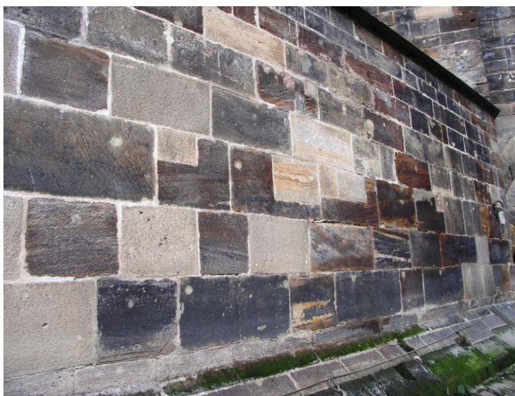
obr. 2 – Praha, Karlův most, východní stěna jižního zhlaví nultého pilíře na němž stojí Staroměstská mostecká věž (foto M. Panáček 2006).
