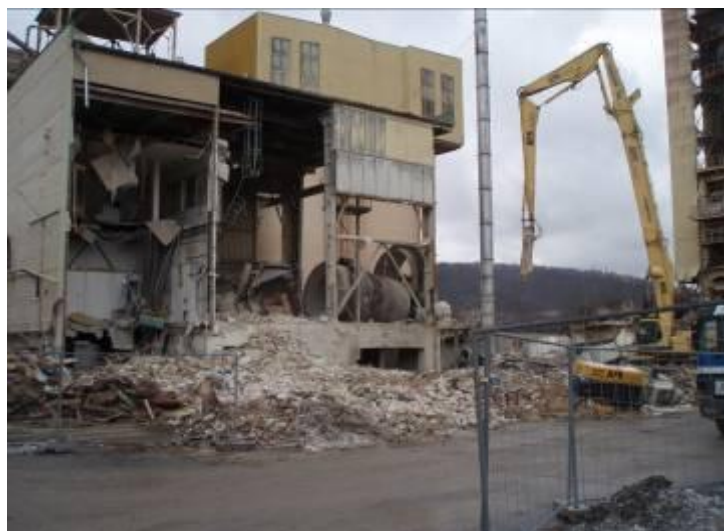
Obr. 4 Demolice technologické výrobní linky s rotační pecí [4]
