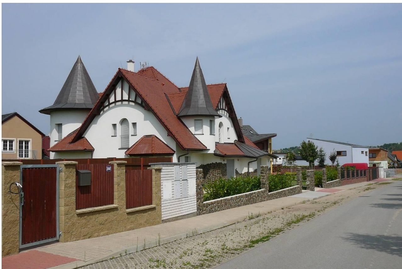
Obr. 1 Roztoky- tvarově nesourodé a typově nevhodné formy zástavby
