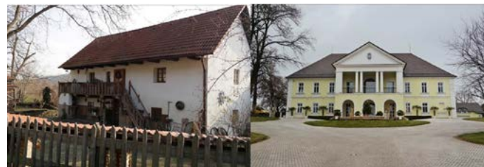
obr. 27 – bývalý mlýn v obci Husinec a zámek města Klecany (v minulosti jádrem komponované krajiny); zdroj: autor
