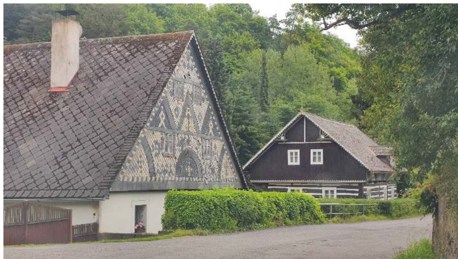
Oobr. 7 - Jedinečná koncentrace lidové architektury patří k rysům krajiny Kokořínska. Na obrázku zděná a roubená architektura ve vsi Tubož (Foto: autor, 2024)
