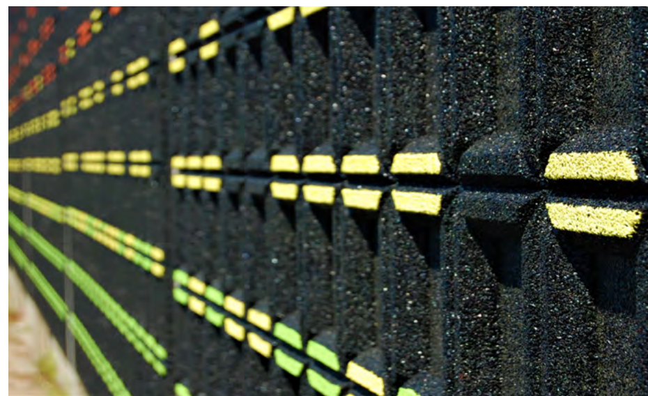
Obr. 2 – Detail stěny noba digi v Nových Jesenčanech na Pardubicku s designem typu „ekvalizér“. (Zdroj: www.egoe-construction.eu )
