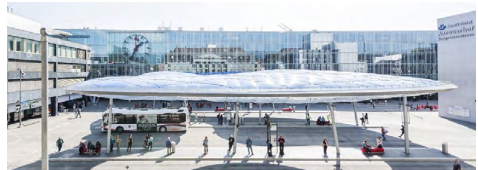
Obr. 6 – Přednádražní prostory a přestupní body veřejné dopravy jsou rovněž lokalitami pro efektivní uplatnění sdílených zón, umožňující přímý a nerušený pohyb cestujících bez zbytečných bariér v symbióze s provozem spojů veřejné dopravy. Řada realizací zejména ve Švýcarsku potvrzuje, že toto řešení vede k větší bezpečnosti pohybu cestujících v prostoru - Bahnhofplatz, Aarau, Švýcarsko (zdroj: foto SBB)
