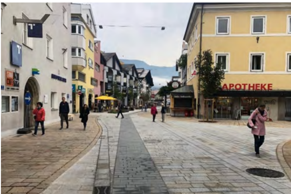
Obr. 9 – Použití několika vzorů a barev dlažby člení plochu, a zároveň vymezuje koridor pro jízdu vozidel a trasu pro cyklisty, jejichž dlouhá linie je záměrně narušena vyosením - Telfs, Rakousko (zdroj: autor)
