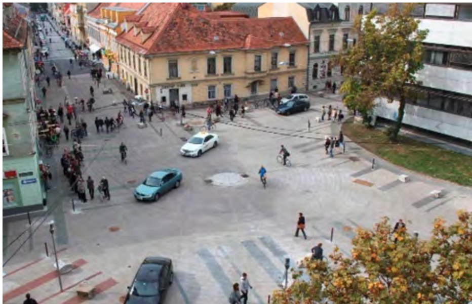
Obr. 4 – Příklad lokálního náměstí realizovaného formou sdílené zóny, jehož převážnou část původně zabírala dopravní plocha křižovatky - Sonnenfelsplatz, Graz, Rakousko (zdroj: TU Graz)
