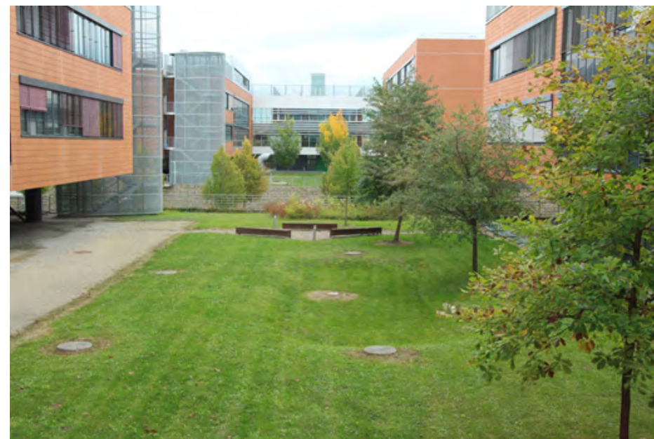
Obr. 5 – Průlehy s retenčními rýhami mezi pavilony kampusu Masarykovy univerzity v Brně-Bohunicích (Zdroj: Eva Kabelková, vodatzb-info.cz)
