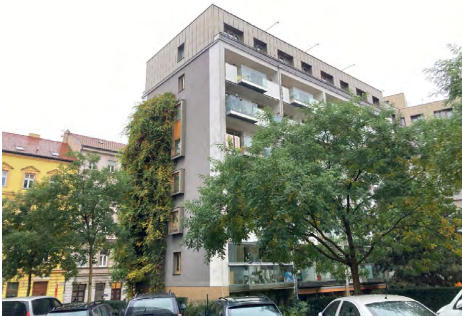
Obr. 8 – Vegetační stěna na Domě s pečovatelskou službou, Praha 3 (Zdroj: fotografie autora)
