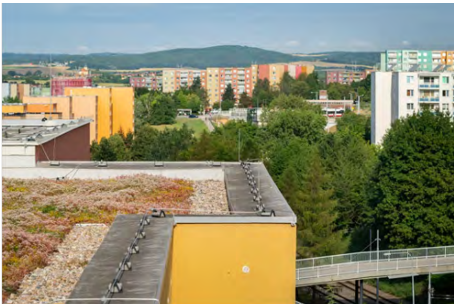
Obr. 3 – Zelená střecha na panelovém domě na sídlišti v Brně (Zdroj: archiv firmy Greentop, adaptterraawards.cz)
