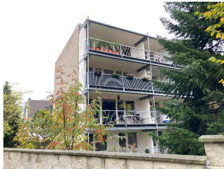
Obr. 7 – Rozšíření panelového domu, Praha 10 (Zdroj: fotografie autora)
