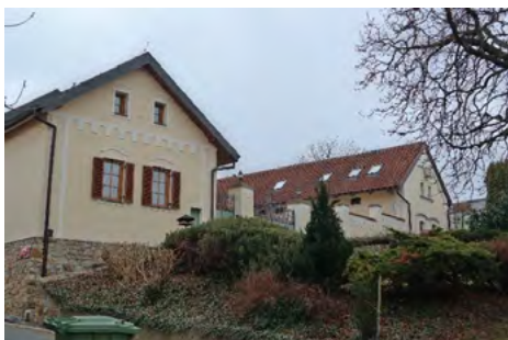
Obr. 21 – Dochovaná a zrekonstruovaná stavba zemědělského areálu v Kolodějích; zdroj: autor
