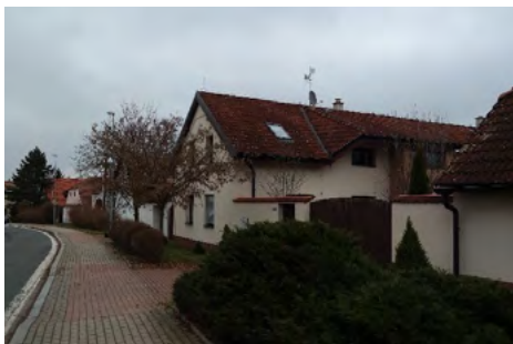
Obr. 31 – Novodobá výstavba samostatně stojících rodinných domů respektující charakter okolní zástavby v Hájku; zdroj: autor
