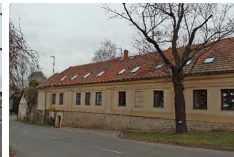
Obr. 44 – Historická budova po rekonstrukci. Dnes areál ZŠ; zdroj: autor
