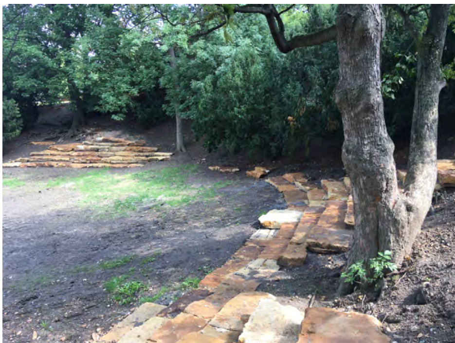
Obr. 19 – Realizace nového amfiteátru (foto: Matouš Jebavý 2022)
