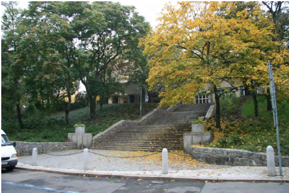
Obr. 8 – Zrekonstruované schodiště před Sokolovnou s novými kamennými sloupky (foto: Matouš Jebavý 2013)
