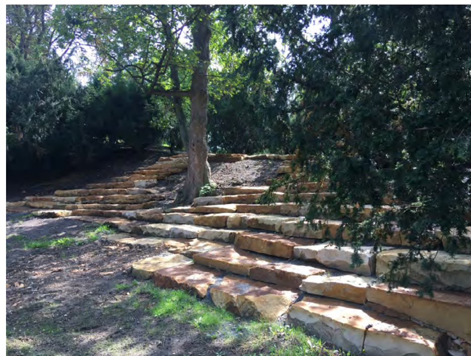
Obr. 18 – Realizace nového amfiteátru (foto: Matouš Jebavý 2022)
