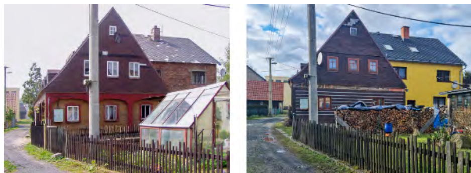
Obr. 11 – Vilémov č.p. 211 - 2003 vs. 2022 – vysoký stupeň neregulovaných změn; zdroj: 2003 - TUR Šluknovsko, 2022 - archiv autora
