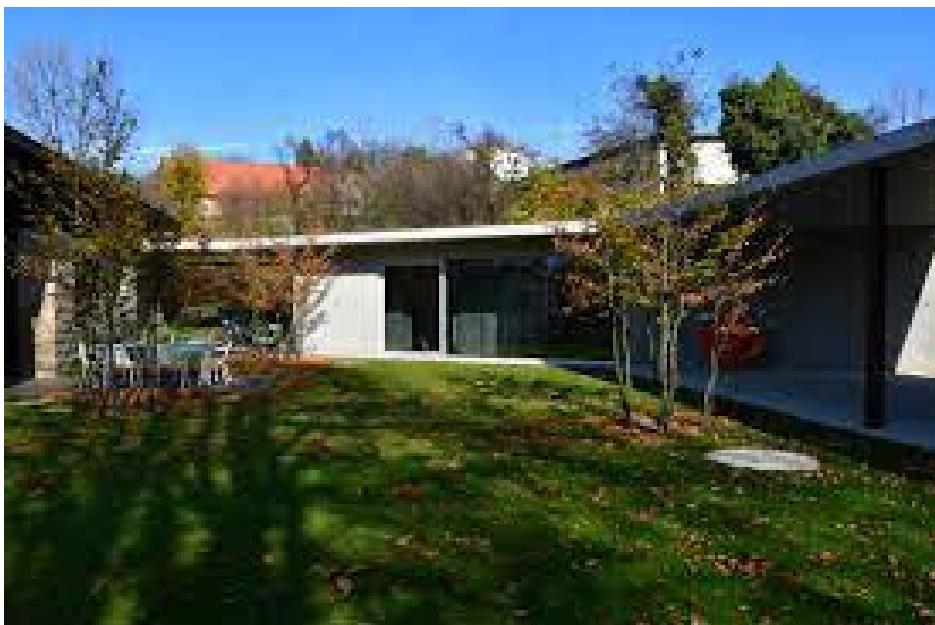
obr. 9 – Dům na Kojetíně – unikátní patio v novostavbě domu, zdroj: Archiweb, 1997-2022
