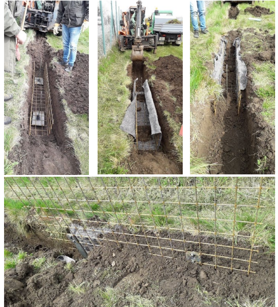
obr. 6 – Konstrukce kari sítí (foto Miroslav Kunt)
