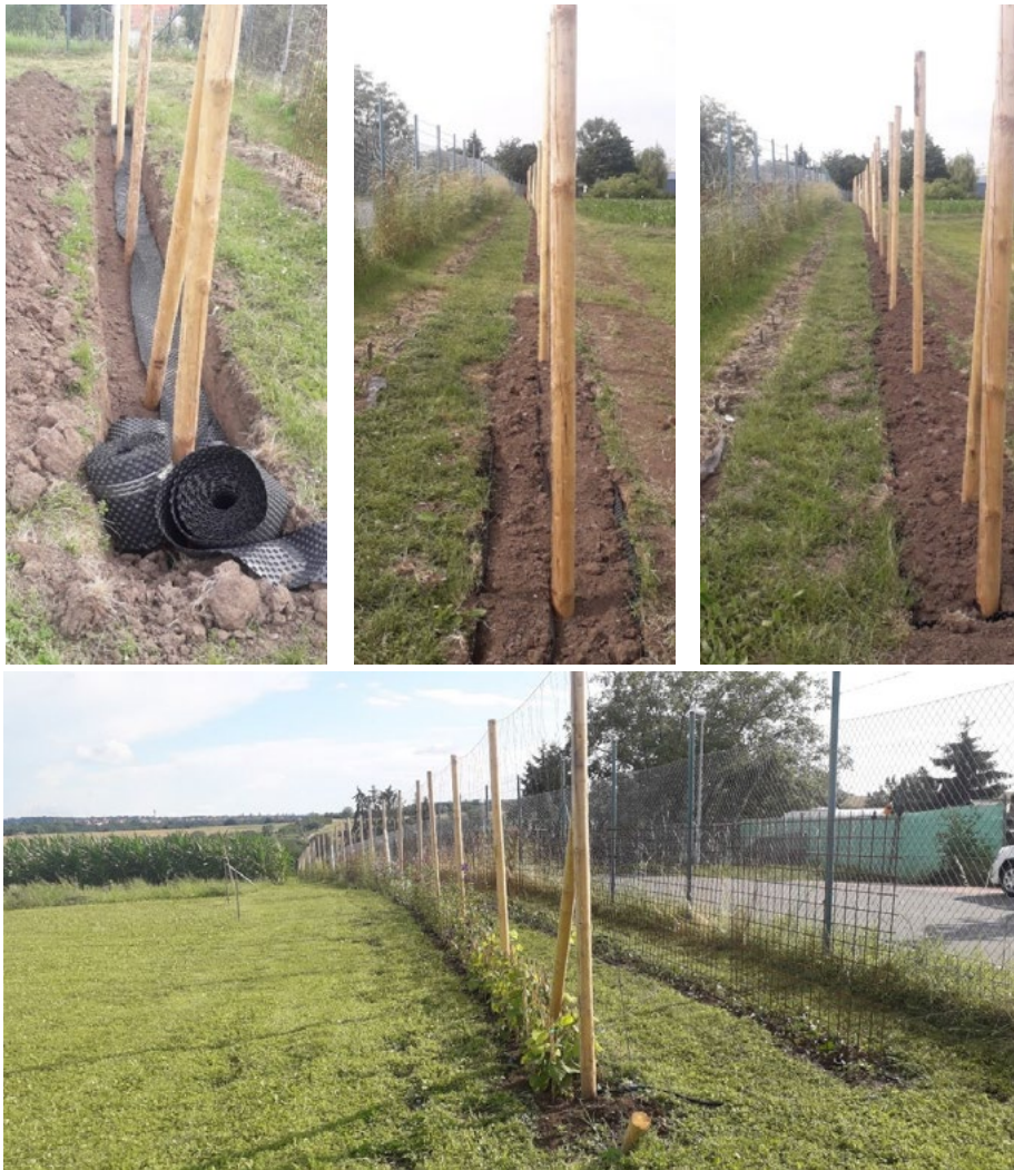
obr. 10 – Instalace lankové konstrukce
