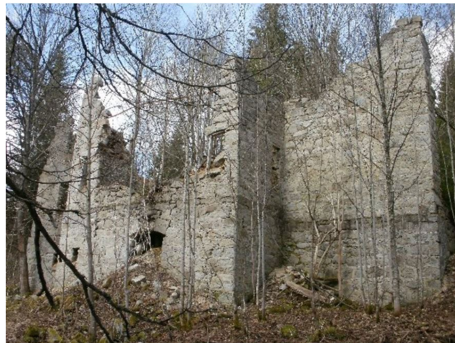
obr. 17 – Horní Světlé Hory – zbytky stavby původní školy, autor Ondřej Kudlák
