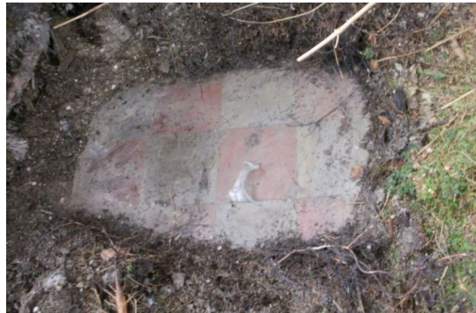
obr. 15 – Horní Světlé Hory – po odkrytí zeminy smrkovým vývratem jsou v rozvalinách domu patrné zbytky původní dlažby. Zde konkrétně u zbytků stavby č.p. 33, autor Ondřej Kudlák
