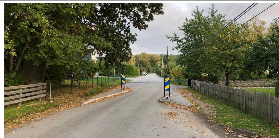
Švédsko, řešení zklidnění ulice uvnitř obytné části města
