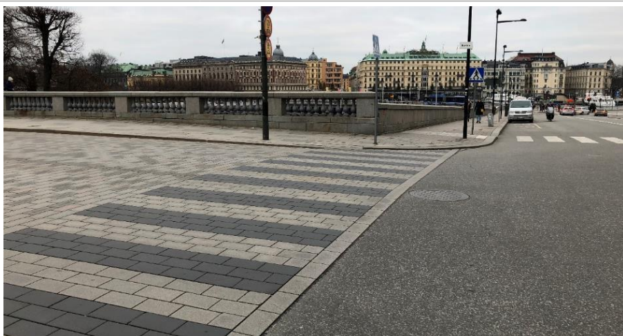
foto č. 1 – Švédsko, zpomalovací pásy v kombinaci s alejí s cyklostezkou po okraji; foto č. 2 – Švédsko, vymezení různých typů komunikací
