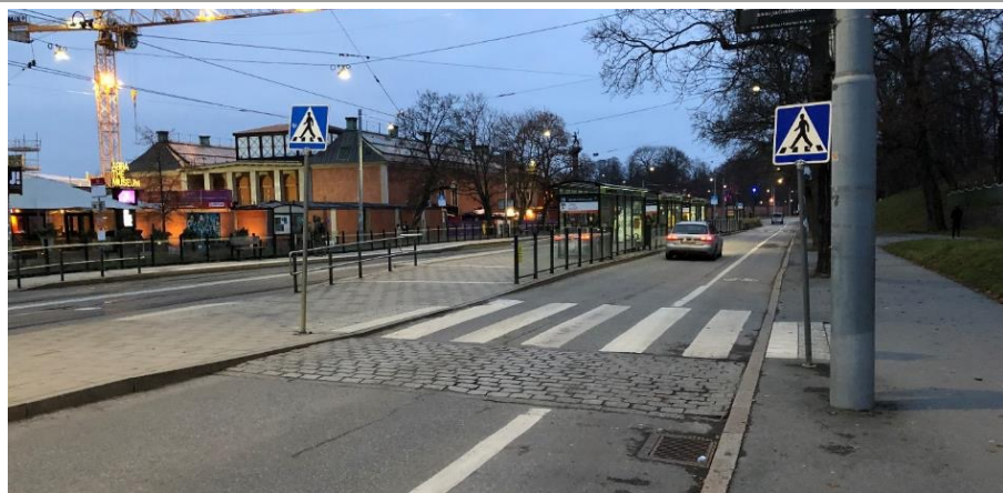
Švédsko, podélný práh kolem zastávky s nájedzy z kamenných kostek
