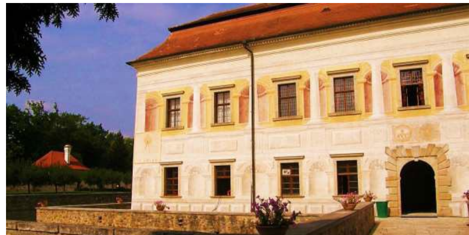
obr. 2 – Letohrádek Kratochvíle; detail vstupního průčelí s iluzivní arkádovou loggií a nikami (foto autor).
