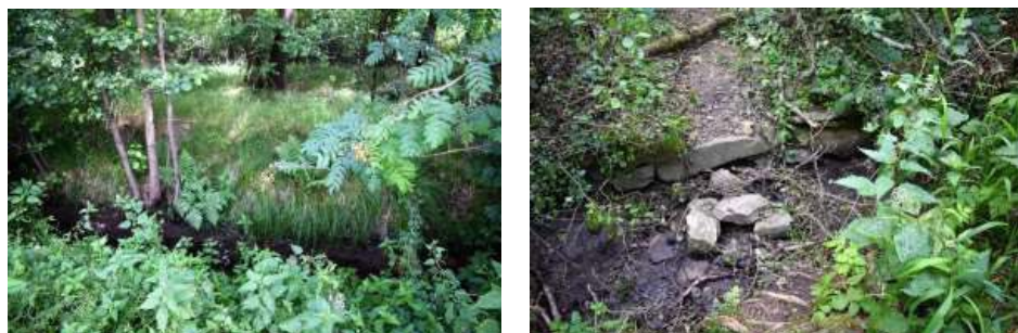
obr. 5 – Vlevo funkční úsek stoky mezi Hrádečkem a rybníkem Dolní Nadýmač. Vpravo detail kamenného ostění úseku stoky pod Hrádečkem. (Foto autor).
