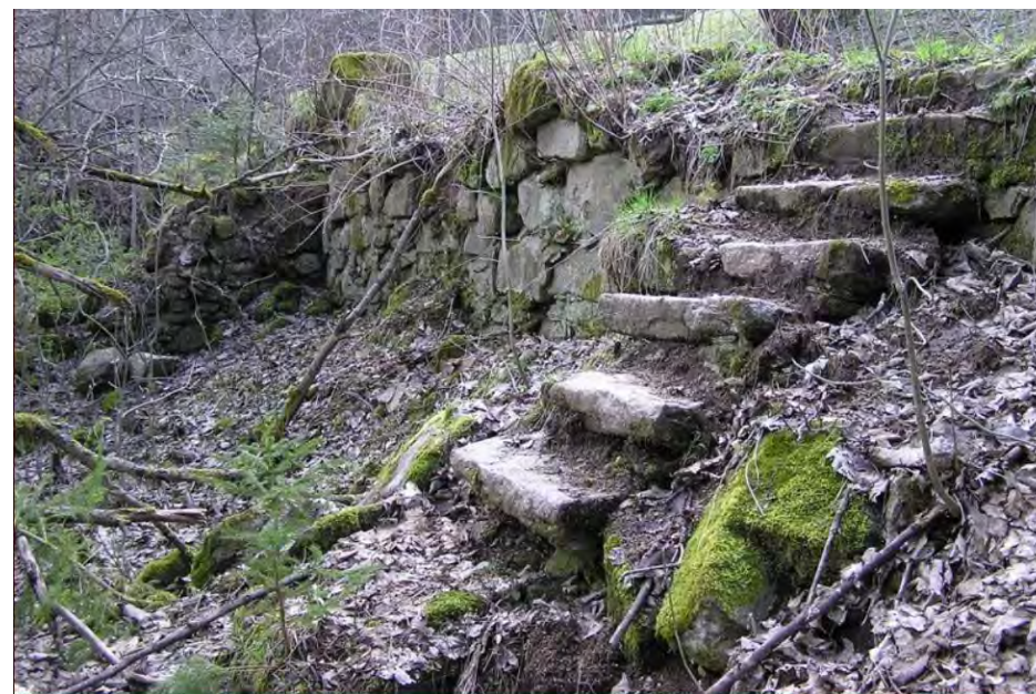
obr. 34 – Stará Hůrka – schody do domu č. 70, autor Martin Čejka
