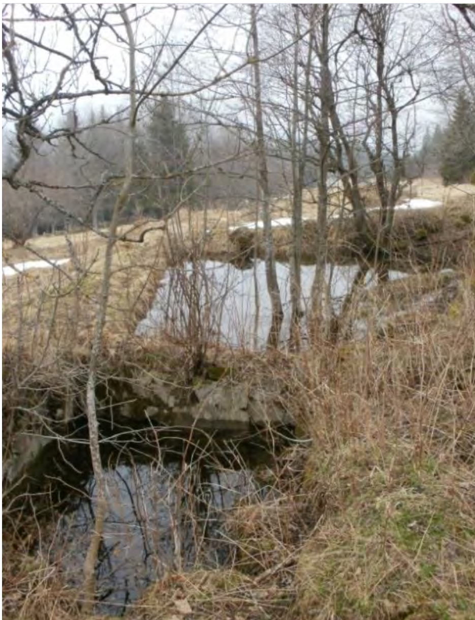
obr. 18 – Točná – vodní nádrže schované mezi nálety dřevin, autor Ondřej Kudlák
