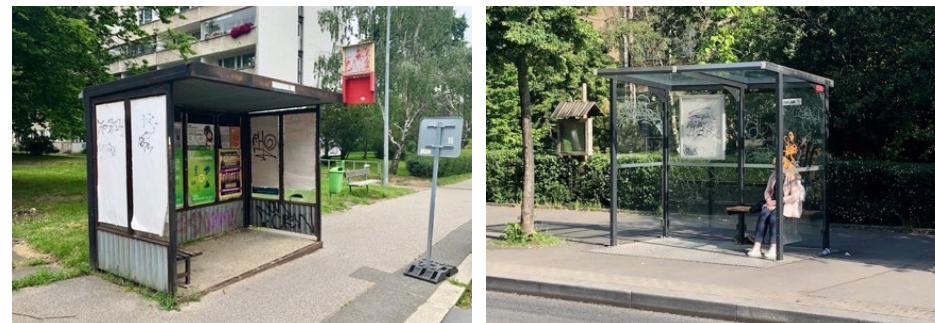
obr. 9 (vlevo) – Provizorní přístřešek na zastávce Prosek (Zdroj: autor)
