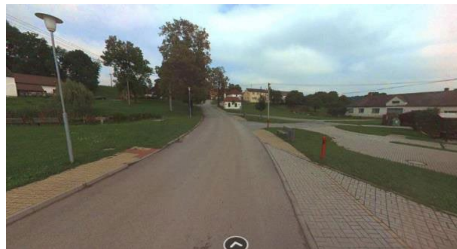
obr. 17 – Neždařilá rekonstrukce povrchů návsi (zdroj panoramatického pohledu: https://mapy.cz/ )
