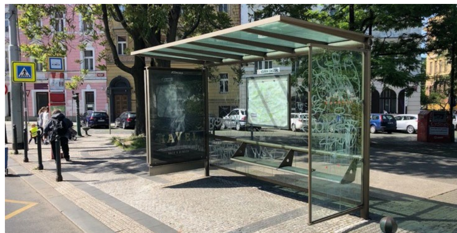
obr. 8 – Unifikovaný přístřešek na zastávce Albertov (Zdroj: autor)
