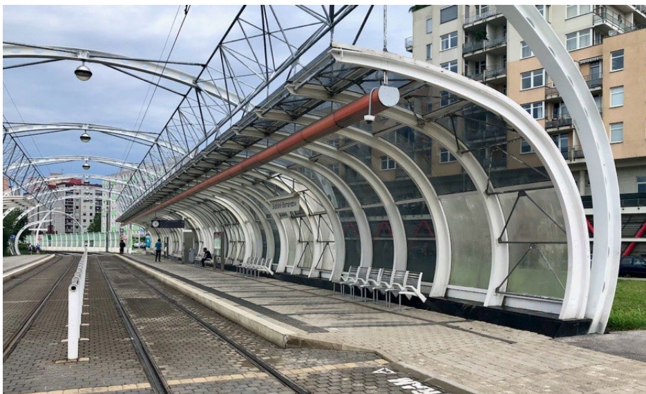
obr. 6 – Zastřešená nástupní zastávka Sídliště Barrandov (Zdroj: nasregion.cz)
