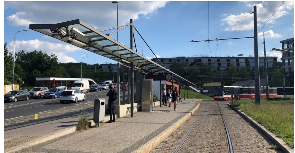
obr. 1 – Zastřešení nástupní zastávky v tramvajové smyčce u stanice metra Radlická (Zdroj: autor)
