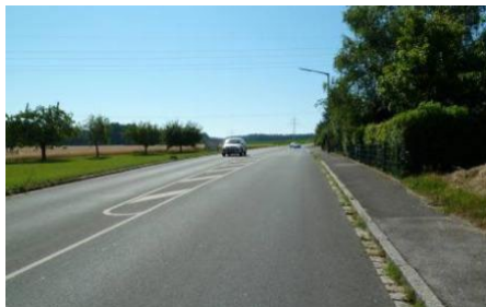
obr. 5 – a) ostrůvek na hranici sídla, směr výjezd ze sídla (Regelsbach – okolí Norimberka) b) středový ostrůvek vyvedený pomocí vodorovného značení (Regelsbach – okolí Norimberka)
