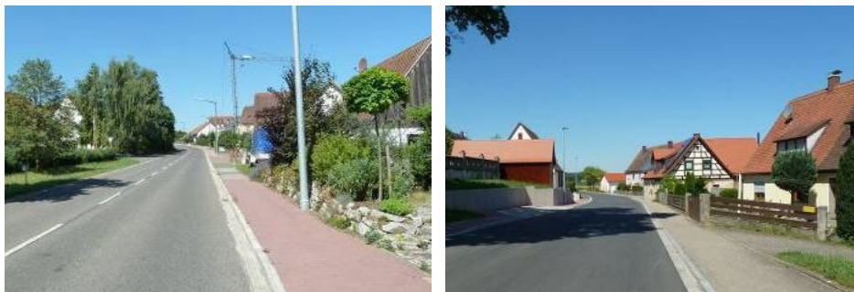
obr. 12 – a) chodník s barevným zvýrazněním (Kottensdorf – okolí Norimberka) b) chodník oddělen od komunikace bezpečnostním proužkem (Rohr – okolí Norimberka)
