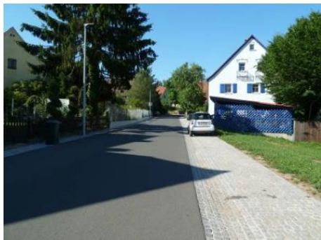
obr. 9 – a) přídlažba na komunikaci (Anwenden – okolí Norimberka) b) přídlažba definující šířku komunikace (Hartau – okolí Žitavy)
