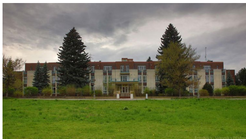
obr. 4 - Rehabilitační centrum Máj (zdroj: https://www.lazne-podebrady.cz )
