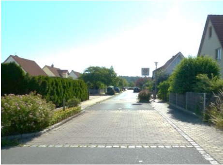
obr. 10 – a) změna povrchů (Anwanden – okolí Norimberka) b) zpomalení na křižovatce (Hartau – okolí Žitavy)
