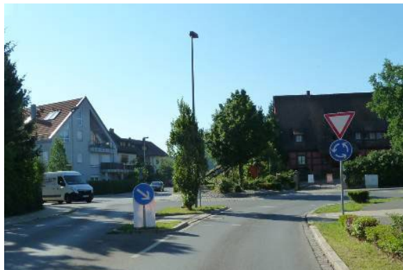
obr. 8 – miniokružní křižovatka (Obersbach – okolí Norimberka)
