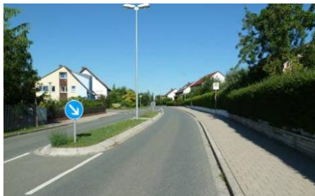
obr. 6 – a) místo pro přecházení - dělicí ostrůvek (Groswiesmannsdorf – okolí Norimberka) b) středový ostrůvek (Stein – okolí Žitavy)
