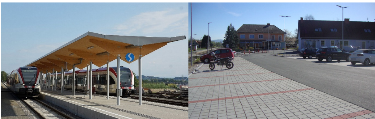
obr. 9 – Rekonstruovaná stanice Voitsberg a nové parkoviště P+R v přednádražním prostoru (Zdroj: autor, 2016)
