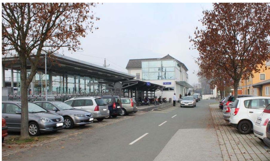
obr. 6 – V rekonstruovaném přednádražním prostoru stanice Karlsdorf bylo vybudováno 120 stání P+R a 150 stání B+R (Zdroj: autor, 2016)
