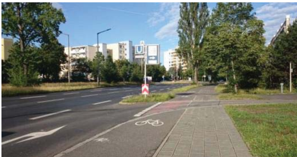
obr. 31- Typický úsek stezky
