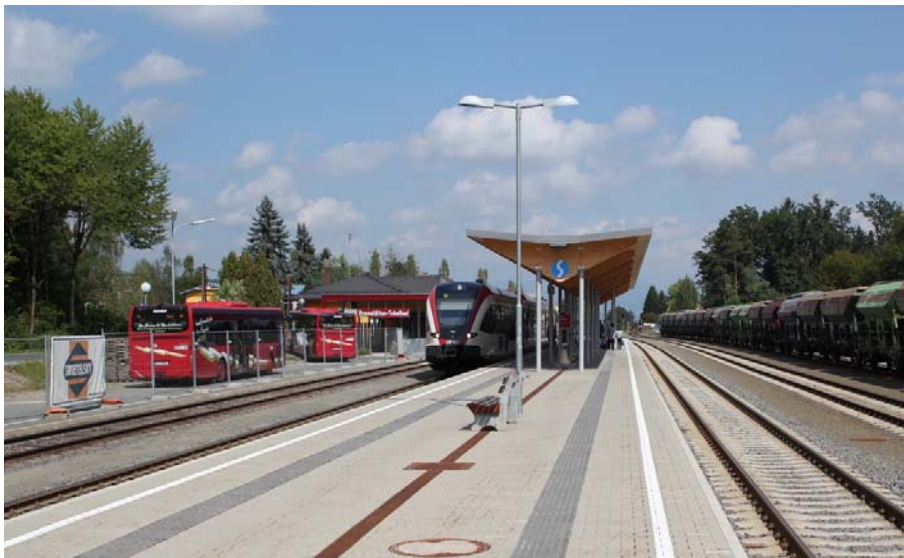
obr. 8 – Rekonstruovaná stanice Tobelbad s terminálem návazné autobusové dopravy (Zdroj: autor, 2016)
