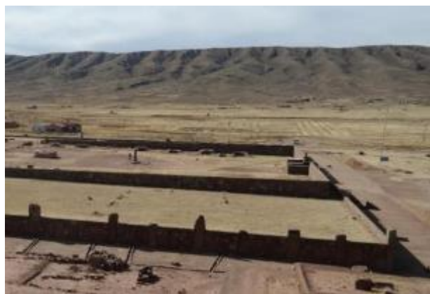
obr. 19 - Dnešní stav po „rekonstrukci“ (Zdroj: vlastní foto 8.9.2016)
