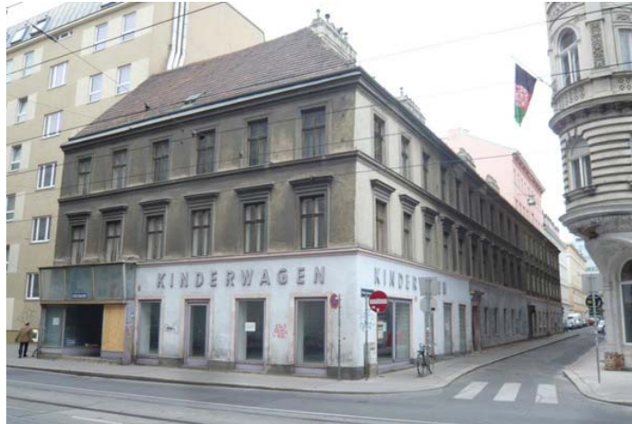
obr. 1 - Opuštěný dům v centru Vídně před rekonstrukcí (Zdroj: Gaupenraub+/-)
