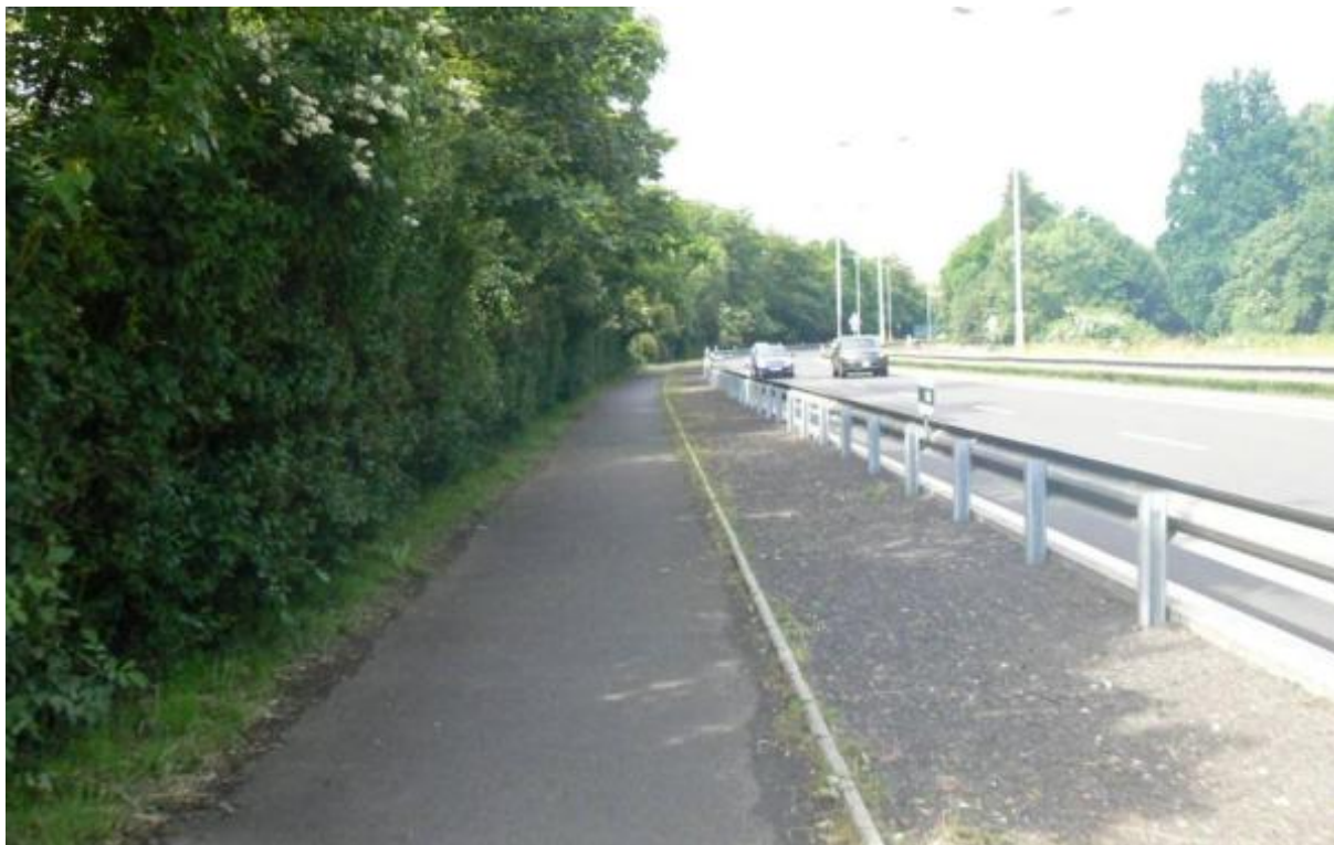
obr. 20 - Vedení stezky souběžně s průtahem
