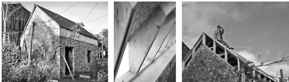
Obr. 10, 11, 12 - Prestavba chlievu na obytný dom, Plougastel Daoulas, arch. Lea le Gall. (foto: autor)
