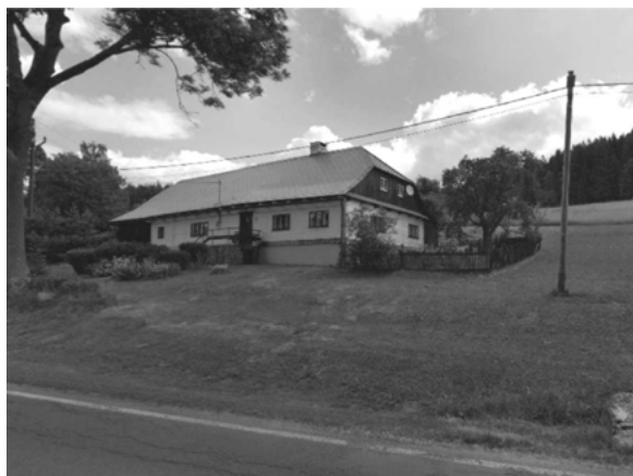
Obr. 6 – Malá Morávka. Nezastavitelný prostor, za historickou stavbou, určen k zástavbě (Zdroj: ÚP Malá Morávka)
