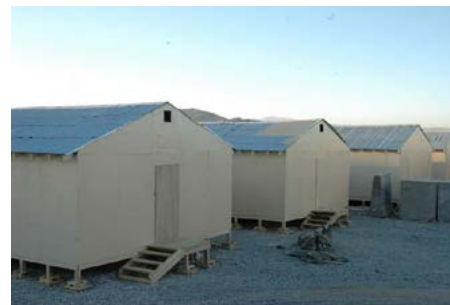
Obr. 22 – Příklad B-HUTS na vojenské základně (Zdroj: Středová, mise.army.cz)
