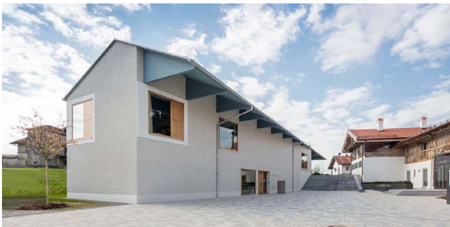
Obr. 10 – Radnice v obci Maitenbeth (zdroj: Meck Frühauf Architekten)
