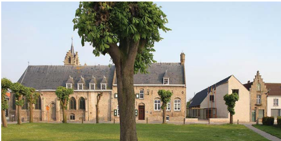
Obr. 21 – Dostavba radnice v Lo-Reninge (vpravo) původního kláštera (zdroj: Hugh Strange)
