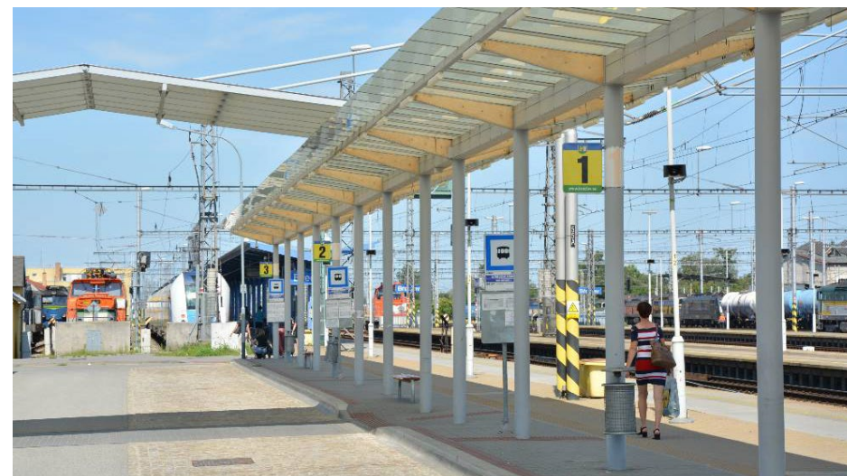
obr. 2 – Dopravní terminál v Břeclavi umožňuje pohodlný přestup „hrana-hrana“ mezi autobusovou a železniční dopravou. Zdroj: Jan Kruntorád, 2021.
