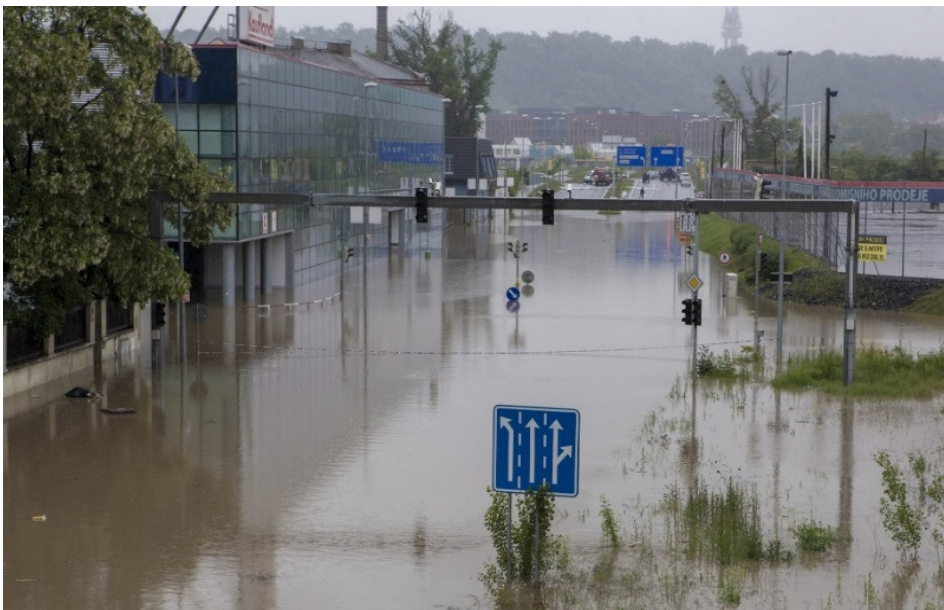
Obr.1 – Lokální povodeň a zaplavení dopravní infrastruktury v Praze 8 na potoku Rokytky po přívalem dešti, červen 2013 (Zdroj: Deník 3.6.2013)
